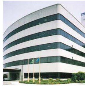
東京電力横浜火力発電所
