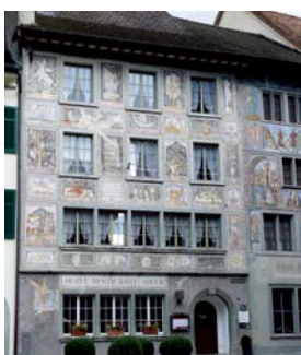
カイム塗料の実績の中で最も古いホテル・アドラー。塗装後130年以上が経過している。
