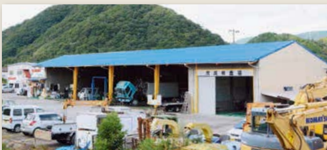
屋根：バイオマスR-Si 広島・自動車修理工場
