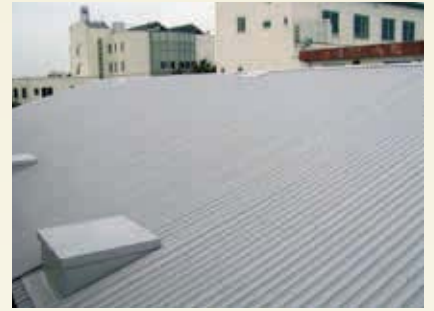
屋根：快適サーモ Bio 愛知県：自動車部品工場
