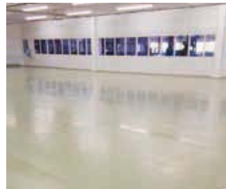
床：ポウジンテックス#2700DG 愛知県：株式会社LIXIL 知多工場
