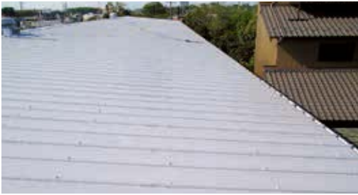
屋根：バイオマスR-Si 埼玉県：倉庫
