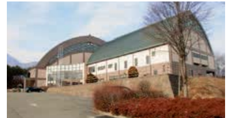
屋根：バイオマス R-Si 山梨県：体育館
