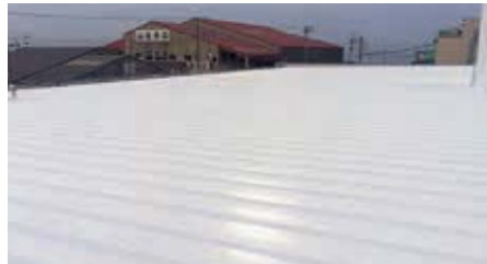
屋根：バイオマス R-Si 千葉県：伯東商事株式会社
