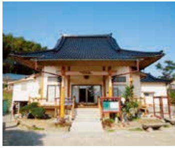
屋根：バイオマスR-Si 鹿児島県：旭保育園
