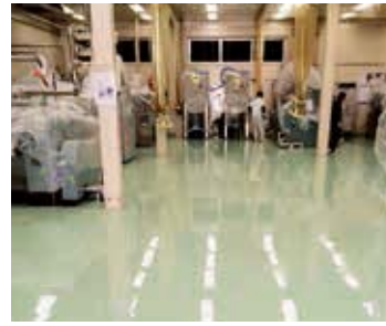
床：ポウジンテックス#8000 岡山県：工場
