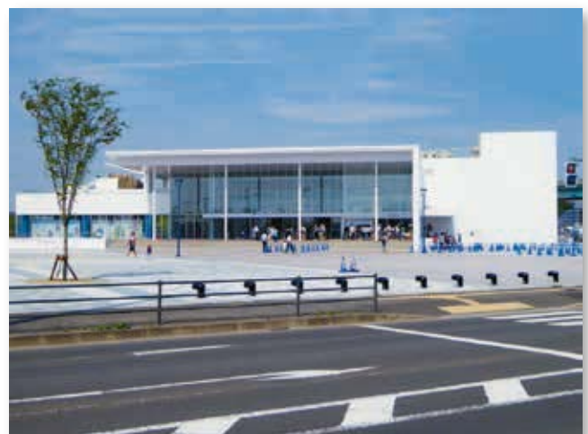
仙台うみの杜水族館
