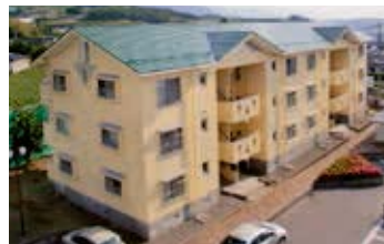
屋根：パワーフロン #1000 山梨県：町営住宅
