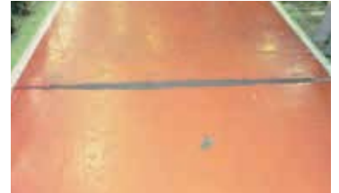
床：穴埋め速乾 神奈川県：自動車整備工場
