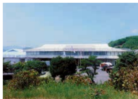
施工中の様子② 左側の棟は塗装が終わり、右側の棟には足場が組まれている
