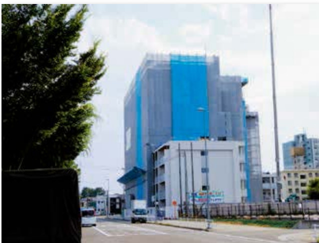
建設中の災害公営住宅
