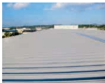
屋根：バイオマス R-Si 福島県：工場 施工：株式会社秋山塗装
