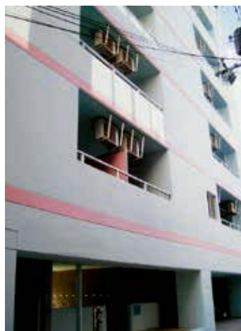
壁：ナノコンボジットW 兵庫県：マンション 施工：樋浦塗装店
