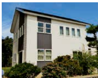
壁：ナノコンボジットW防藻+ 秋田県：戸建住宅 施工：佐々木塗装
