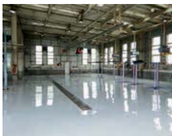
壁：ポウジンテックス タフタイトU 岩手県：自動車サービス工場 施工：アスク新潟株式会社
