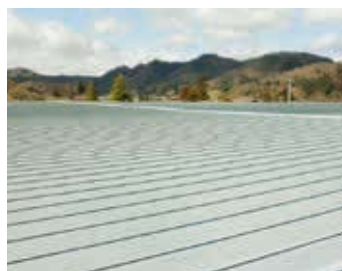
屋根：バイオマス R-Si 福島県：商業倉庫 施工：有限会社菅野塗装
