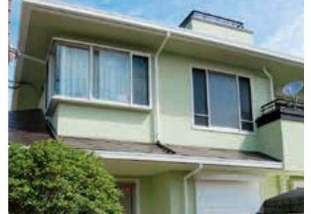
福岡県：戸建住宅 屋根：快適サーモ WSi 壁：ナノコンポジット W 施工：木村塗料(株)工事部
