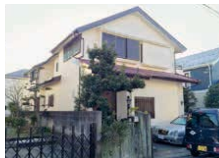
神奈川県：戸建住宅 壁：ナノコンボジットW 施工：(株)HAMA 塗装
