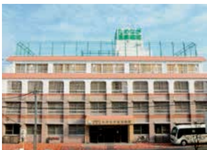
大阪府：医療法人清順堂ためなが温泉病院 屋根：快適サーモ Bio 壁：ナノシリコン W 施工：(株)小野工建
