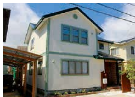
広島県：戸建住宅 壁：ナノコンボジットW 施工：(有)リブルクリエイト
