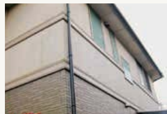
塗装前:壁面に藻が発生し、屋根、壁共に白化していた。
