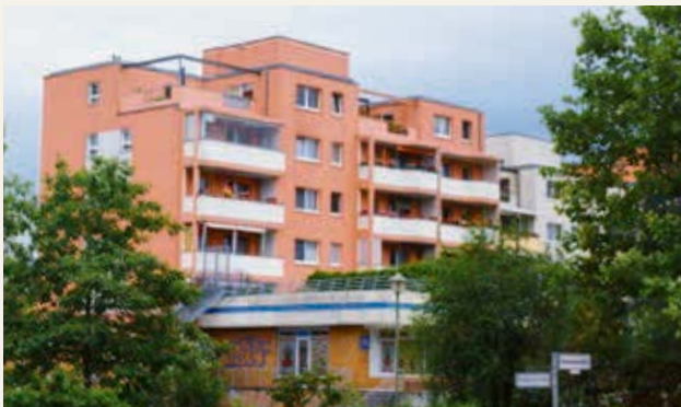
プラッテンバウ 減築により集合住宅の上の階が取り除かれている。
