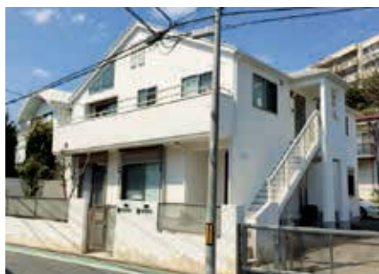
神奈川県：戸建住宅 壁：ナノコンボジットW 施工：(株)HAMA 塗装
