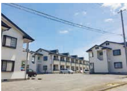
福島県：南湖ウイング 壁：ナノシリコン W 施工：山田塗装(有)
