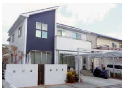
広島県：戸建住宅 壁：ナノコンボジットW 施工：(有)リブルクリエイト
