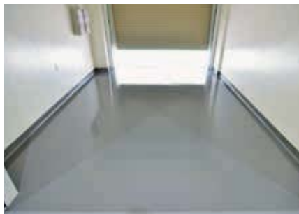
神奈川県：倉庫 床：ポウジンテックス#8000 施工：(株)日誠cfc
