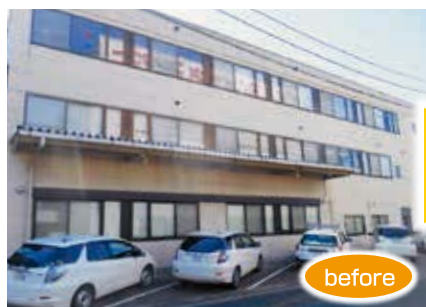
埼玉県：大谷ビル 壁：ナノシリコン W 施工：(株)南雲建装
