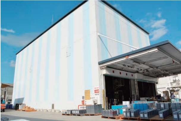
写真1 水谷ペイント本社内自動倉庫 竣工1987年8月18日 上塗：水系ポリマ
