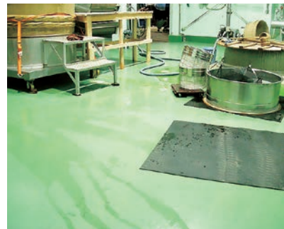
床にボウジンテックス#2000を施工いただいた蔵の様子
