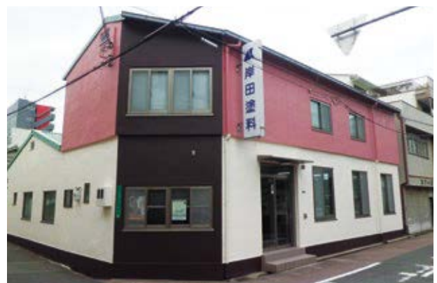
本社屋 昨年外壁をナノコンポジットWで施工
