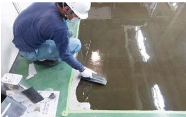
シールプライマー施工中の様子
