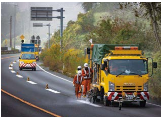
交通安全施設工事の様子
