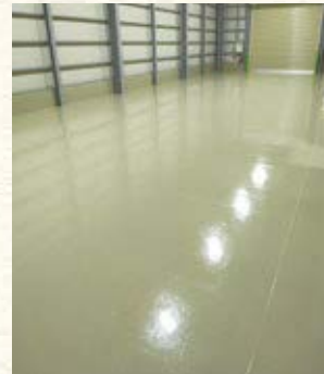
NCC株式会社 長野支店 新築倉庫(長野県)
