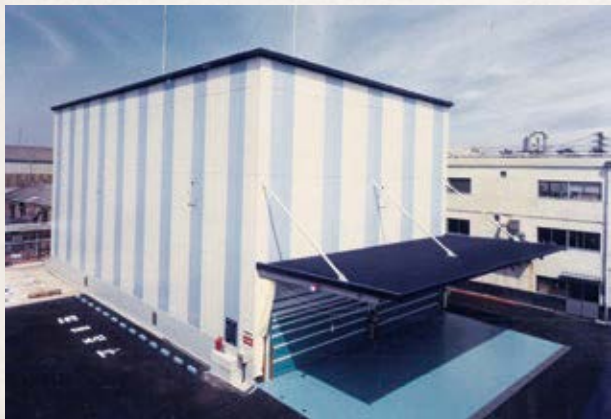
完成当時の立体自動倉庫
