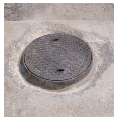
素地調整完了
