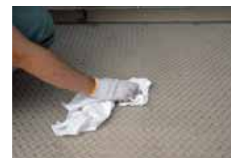
電気メッキ鋼板や既設の光沢の鈍い溶融亜鉛メッキ鋼板はシンナーにて脱脂処理を行う。
