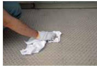
シンナーをしみ込ませたウエス等で入念に防錆油の除去を行う。
