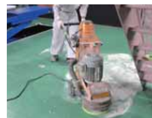
研削機で研削する。
