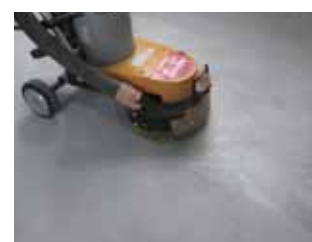
研削機にて目粗しする。
