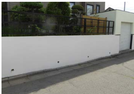
コンクリート製擁壁
