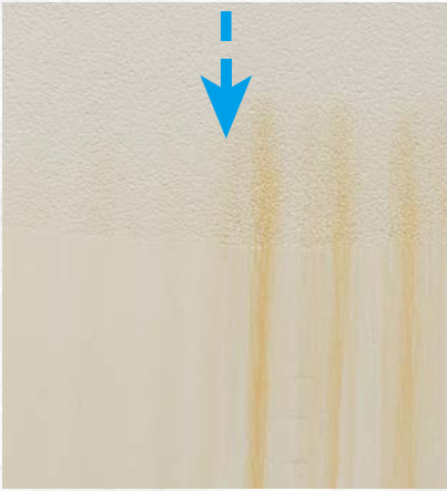
さび汚れ耐性暴露試験：大阪6か月
