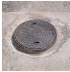
素地調整完了
