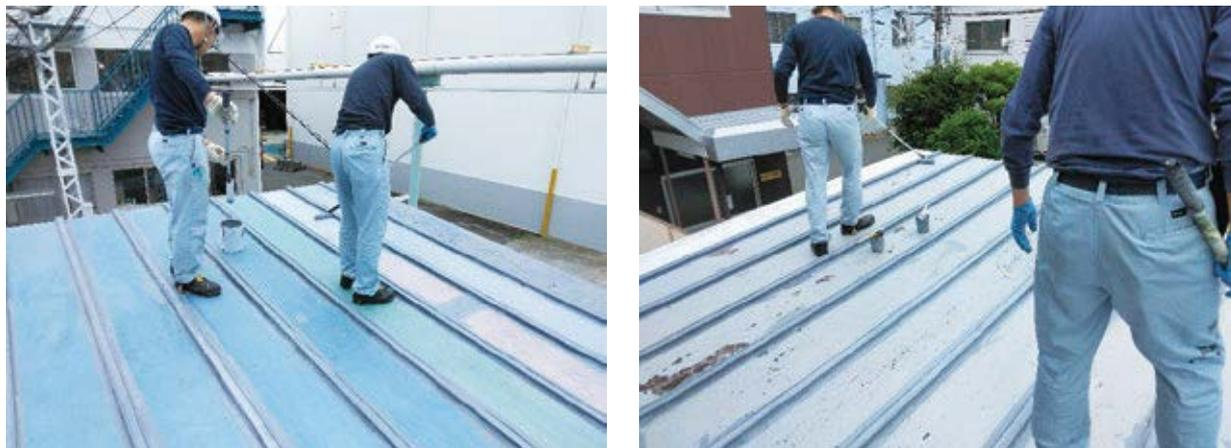
写真4 水系ハイエボンⅢ テスト塗装の様子
