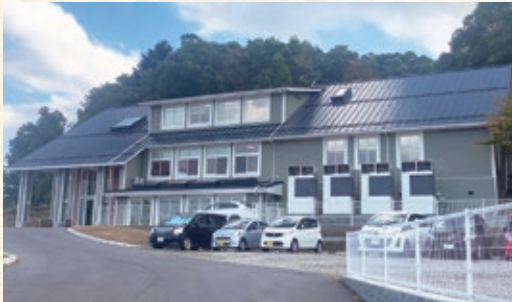
学校(宮城県) 屋根：パワーシリコンマイルドⅡ 施工：有限会社泉塗装 様
