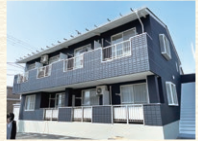
アパート(福島県) 壁：ナノコンボジットW 施工：武田塗装興業株式会社 様
