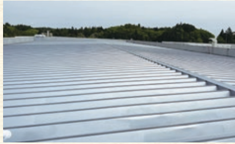
工場屋根(福島県) 屋根：NADポリマSi 施工：エスエーケント株式会社 様
