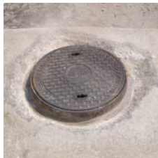
素地調整完了
