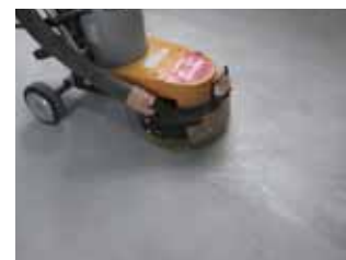
研削機にて目粗しする。
