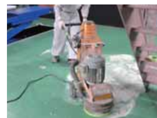
研削機で研削する。
