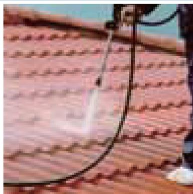
高圧洗浄しながらマジックロンやデッキブラシを用いて脆弱な着色スラリー層を除去します。(洗浄機水圧) 12MPa 120kgf/cm<sup>2</sup>以上。水洗後の洗浄水は着色する場合があります。直接水に流さず回収してください。
