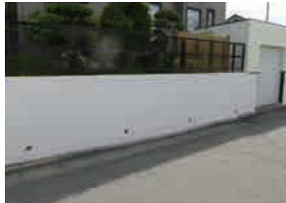
コンクリート製擁壁
